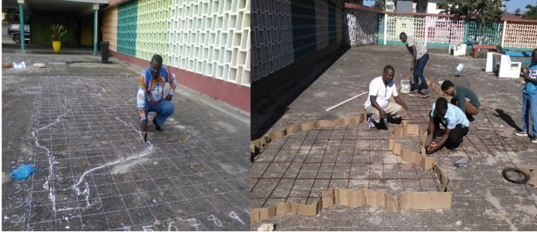
Fig 2: Desenho do mapa no terreno e montagem do escantilhão
