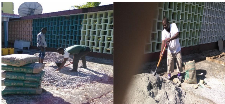
Fig 3: Preparação de massa para betonagem
