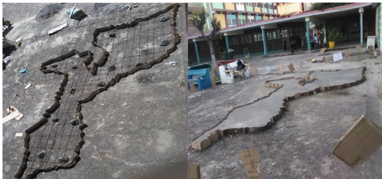
Fig 4. Betonagem do mapa a partir do escantilhão montado
